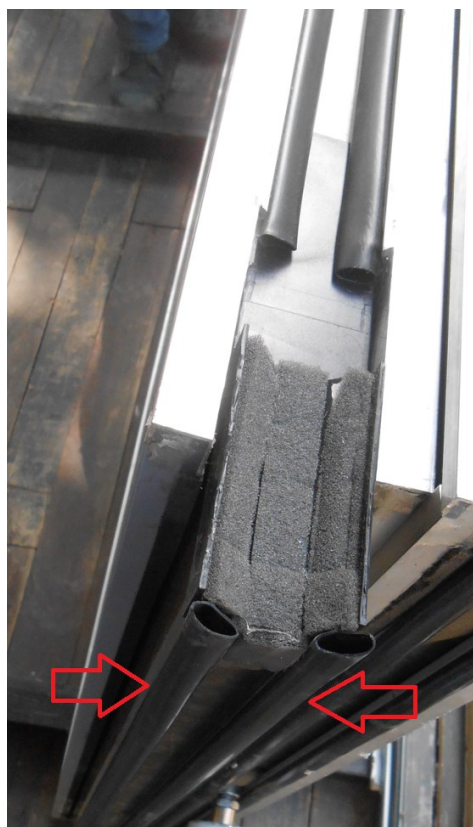
Figura 10 – Vedações com movimentação vertical presentes nos lados inferior e superior dos módulos de vidro para vedação entre os módulos e o pórtilco.
