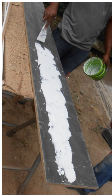
Figura 3 – Aplicação de selante acrílico na interface entre os painéis de madeira da base e o pórtico
