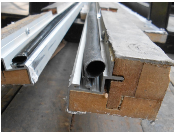
Figura 6 – Perfis que compõem os montantes terminais laterais.
