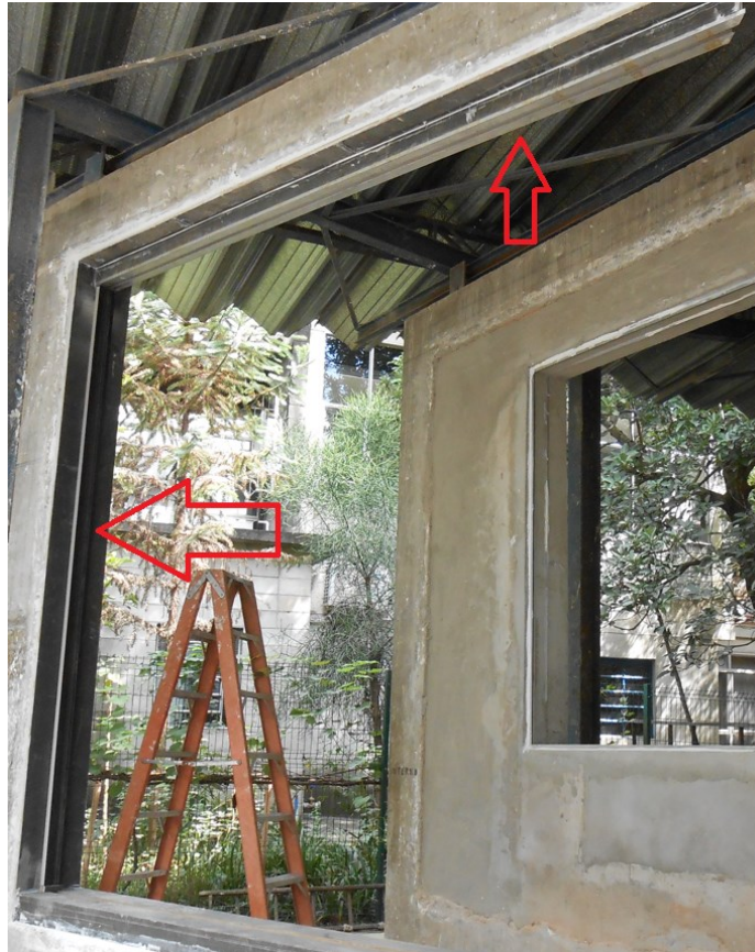
Figura 5 – Instalação do montante terminal do lado esquerdo e trilho superior.
