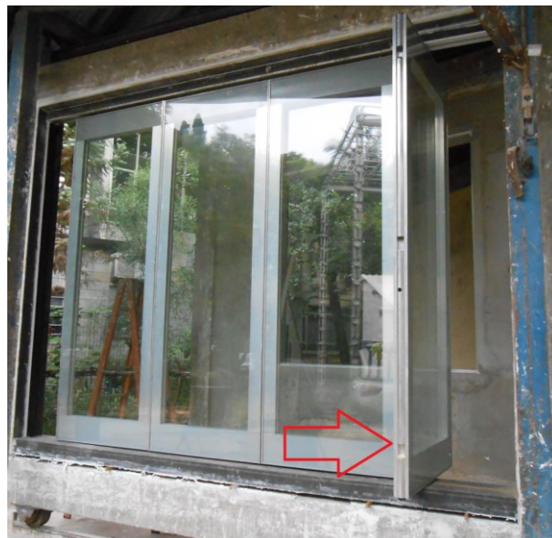
Figura 9 – Movimentação dos módulos.
