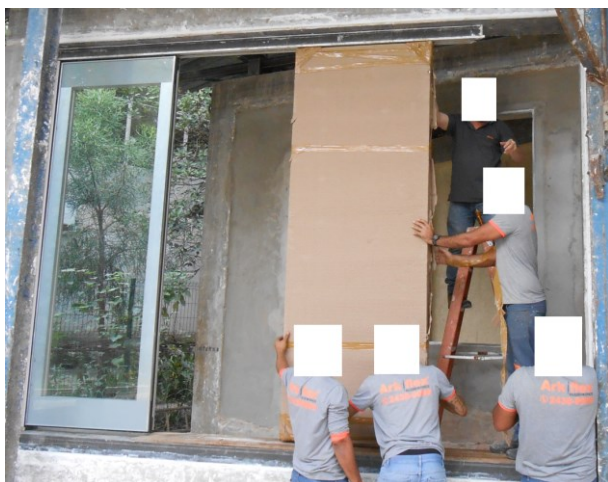
Figura 8 – Instalação dos módulos.
