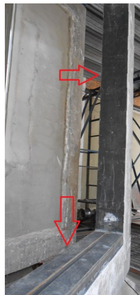
Figura 2 – Instalação da base perimetral sólida de painéis de compósito de madeira.
