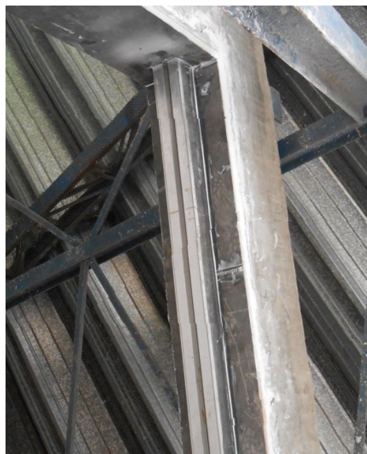
Figura 4 – Instalação do montante terminal do lado direito.
