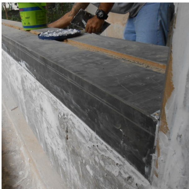
Figura 1 – Instalação da base perimetral sólida de painéis de compósito de madeira.
